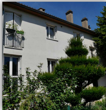
- Entretien de la toiture
